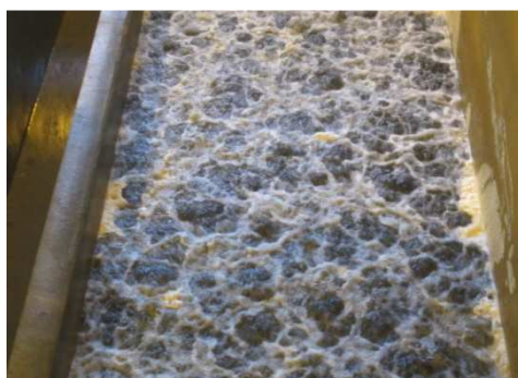
Интенсивное перемешивание активного угля в процессе штатной промывки
